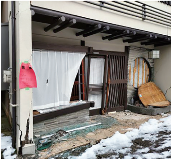
応急危険度判定(能登町役場周辺 1/8(月)～)
